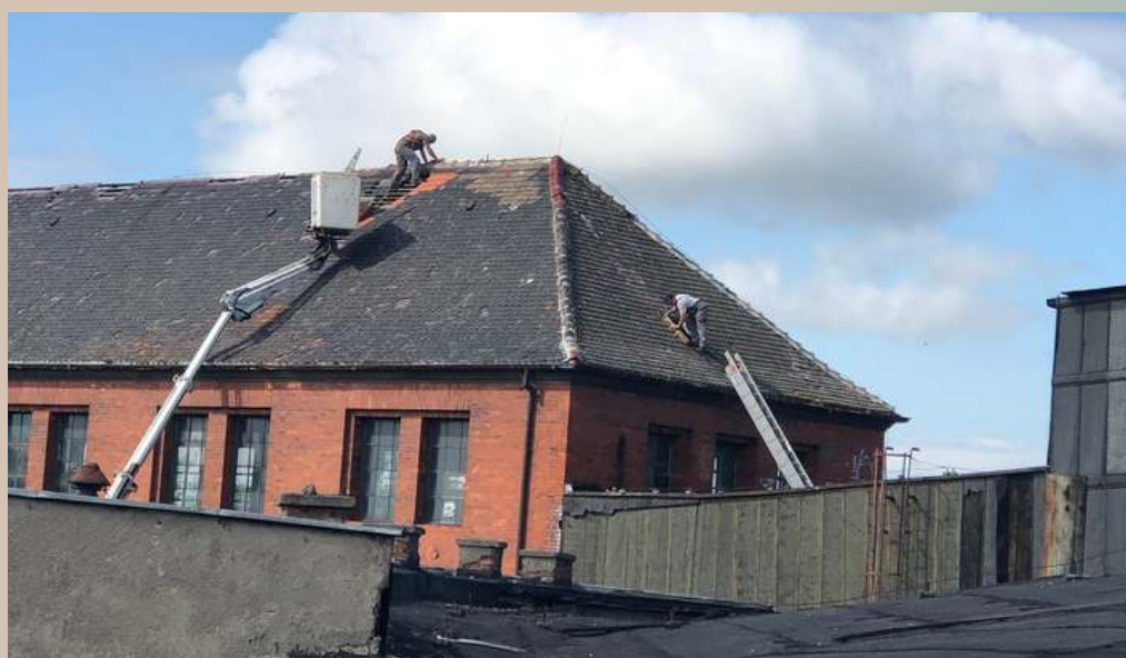
Naprawa dachu hali suwnic wykonana przez PKP SA - 2019 rok
