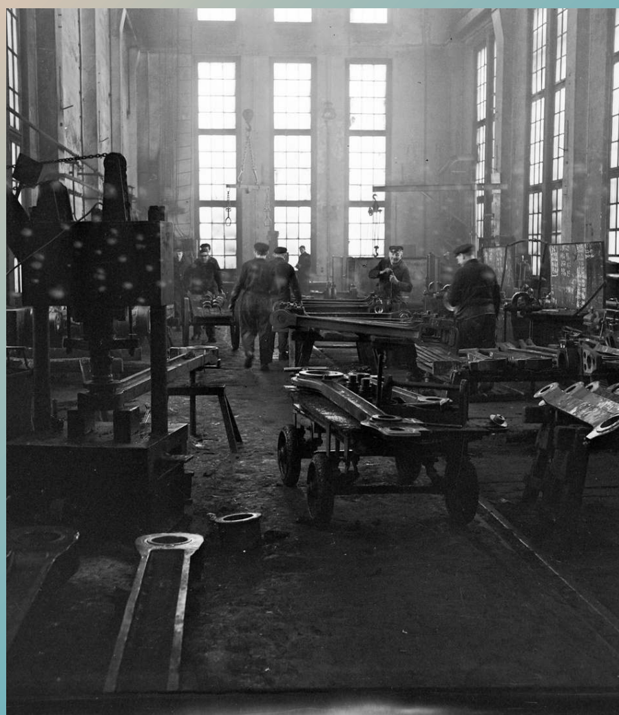
Fotografia przedstawiająca pracowników wykonujących prace przy naprawie parowozów w hali suwnic gnieźnieńskiej Parowozowni. Fot. Janusz Chlasta
